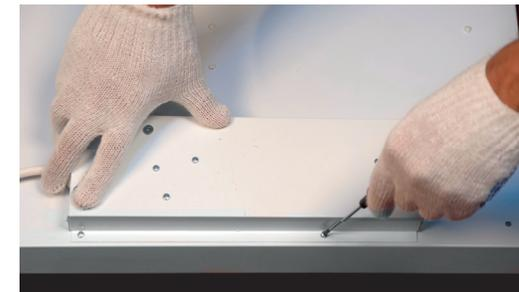
Необходимый крепеж прилагается (винт - 3 шт., гайка - 3 шт., шайба стопорная - 3 шт.)
